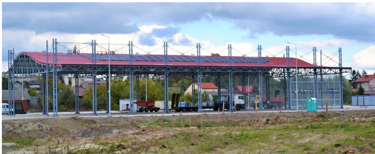
Rysunek 25 Instalacja fotowoltaiczna o łącznej mocy 18 kWp działająca na potrzeby zrewitalizowanego targowiska [Urząd Miejski]
